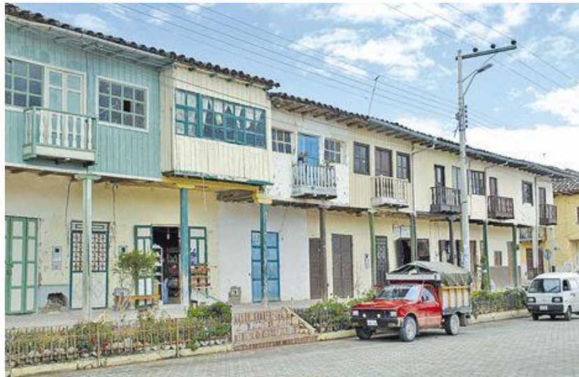
Fotografía 1.3.7.1-2.- CASAS DE ESTILO COLONIAL EN NABÓN CENTRO
