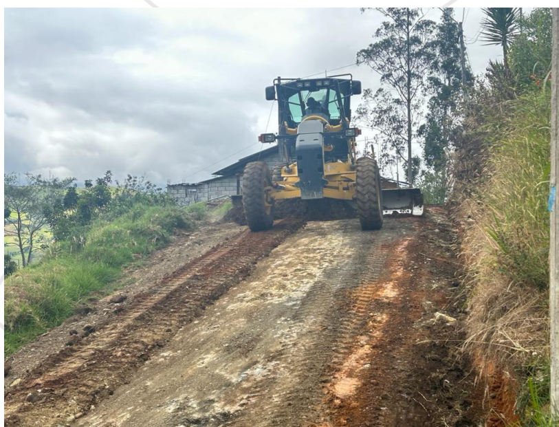
MANTENIMIENTO VAL CANTÓN EL PAN
