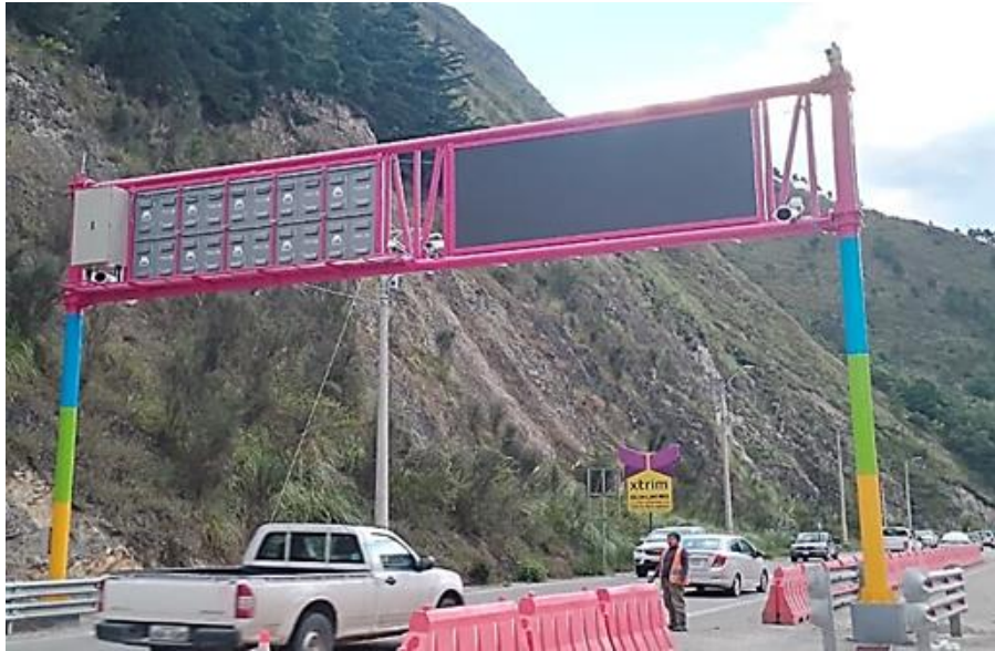
Gráfico 92 PORTAL DE SEGURIDAD – CHAQUILCAY - GTI311
