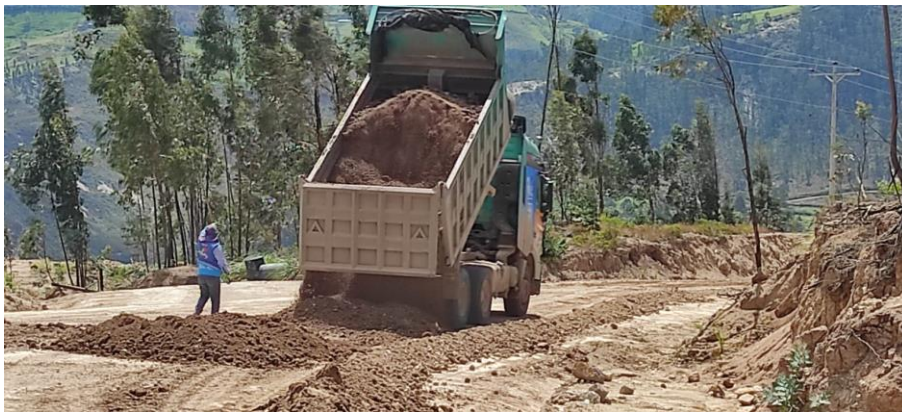
Gráfico 12 MANTENIMIENTO VIAL EN EL TRAMO OÑA - BAIJÓN, CANTÓN OÑA - IYS101
