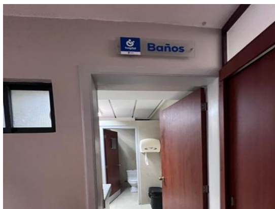
Fotografía 14. Servicios higiénicos (E1, P1).
